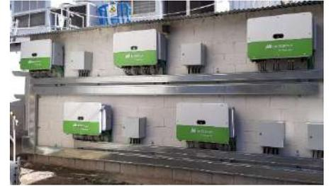
Un **inversor fotovoltaico en string** es un convertidor que transforma la energía de corriente continua procedente del módulo fotovoltaico en corriente alterna (como la de la red eléctrica)
